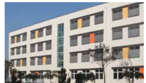
天津朱塘庄中学 Tianjin Zhutangzhuang School
